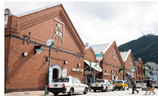
ロマン薫る、海辺の赤レンガ倉庫
